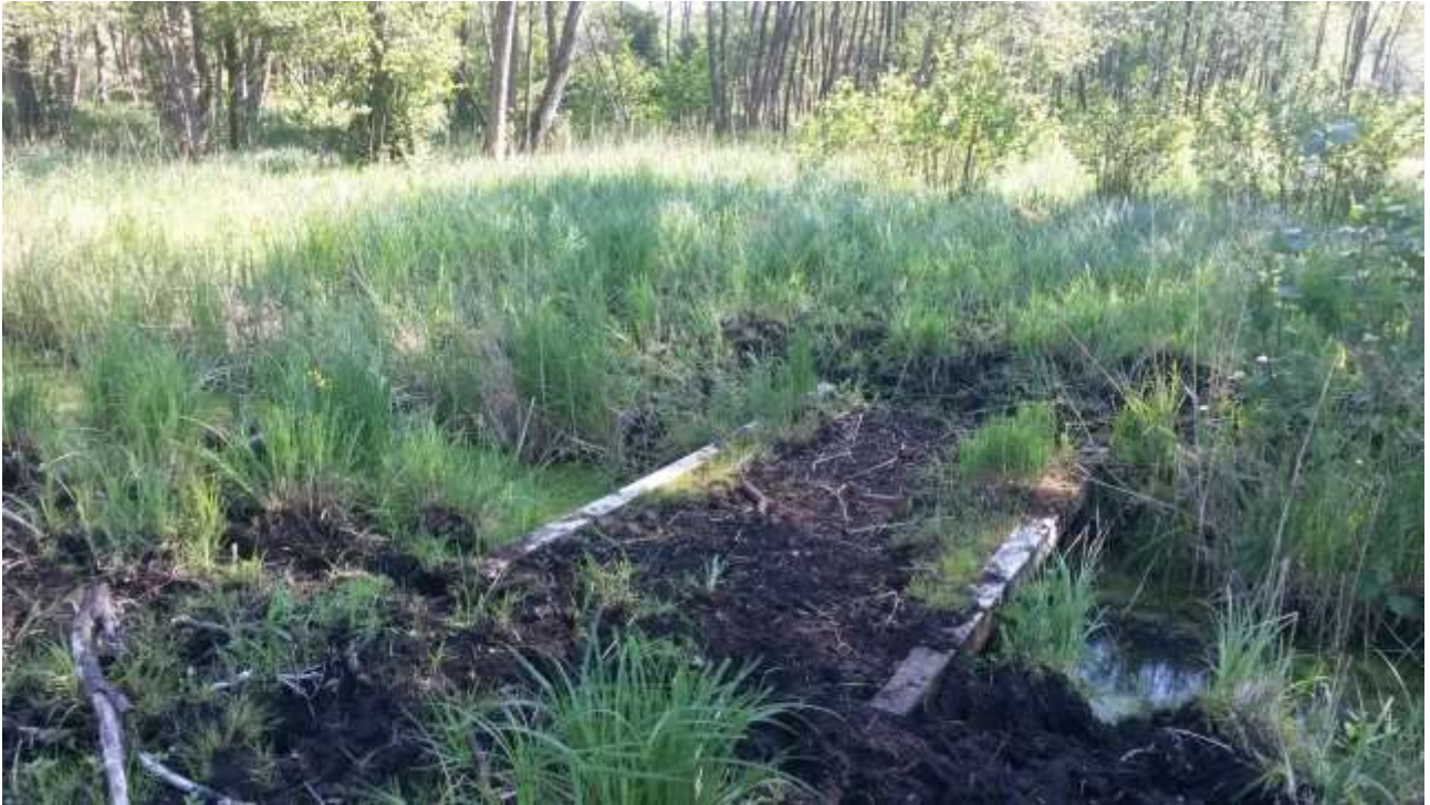
Figur 24. En spang er etableret så der er adgang over grøften.
