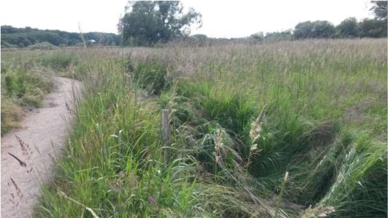
Figur 27. Her har der ikke været græsset endnu, men det har været nødvendigt at slå under hegnet. De høje, kraftige græsarter er Rørgræs og Høj Sødgræs. Svinget lige nord for broen set mod sydvest, folden F3 til højre i billedet. Foto d. 15.6.2016.
